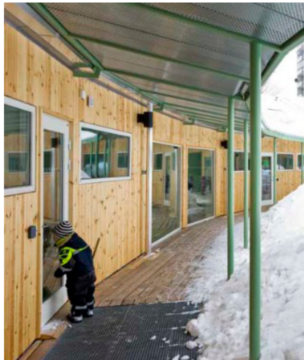
Exempel på visuell koppling mellan gård (friyta) och entré. Ugglan Förskola, Botkyrka. 3dO arkitekter
