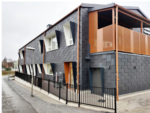
Varumottag och vidbyggt miljöhus. Glavsforden Förskola, Stockholm. Arkitekt: Niras Arkitekter. Landskapsarkitekt: AFRY. Foto Linus Flodin
