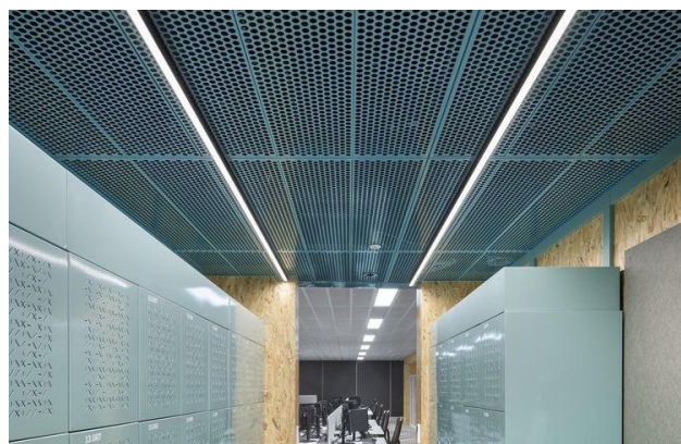
Undertak i perforerad metall som tillåter bakomliggande akustikabsorbenter.
