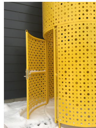
Exempel på omsorgsfull gestaltning av utrymningstrappa. Humlan Förskola, Stockholm, Niras Arkitekter
