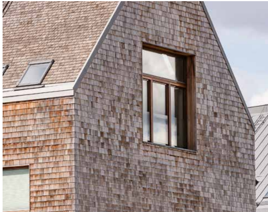
Träspånsfasad på Strandparken, Wingårdhs.
